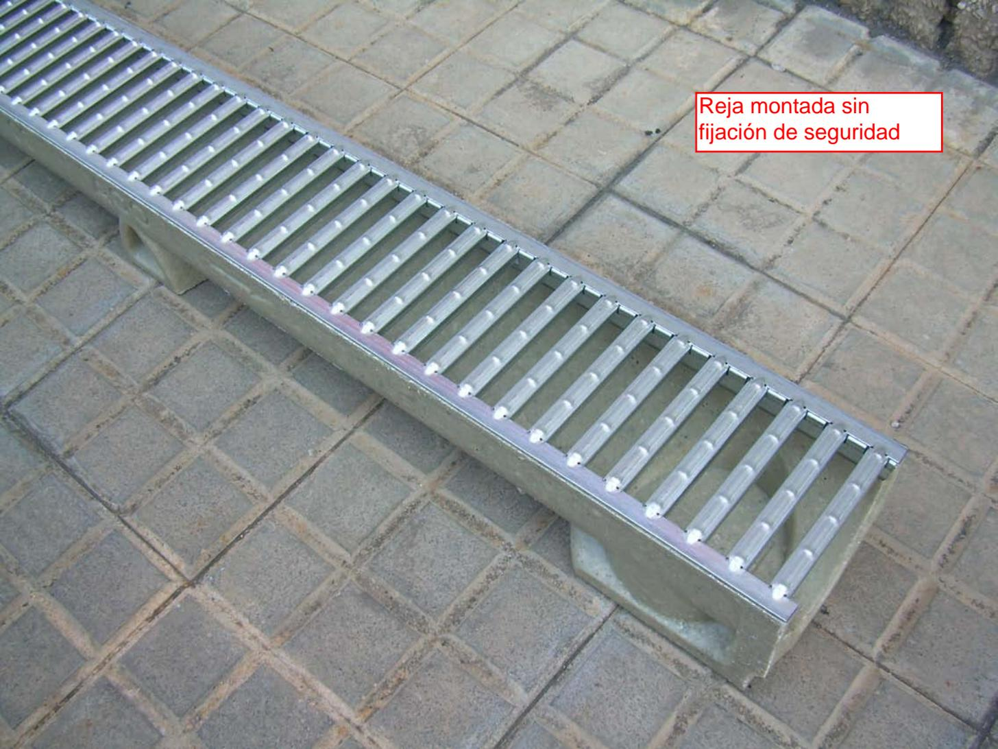
Reja montada sin fijación de seguridad
