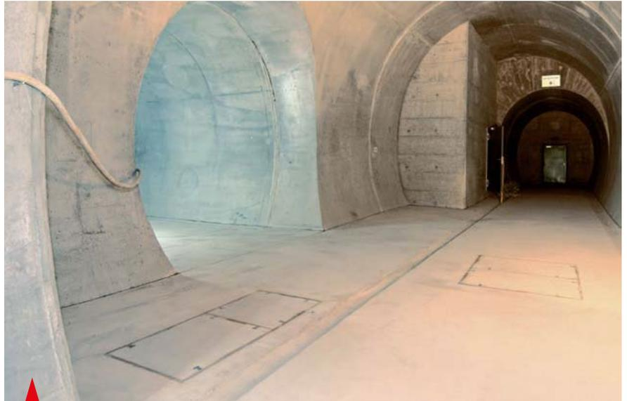
Las tapas de registro de ACO utilizadas como accesos para inspección en el túnel de Wattkopf.
