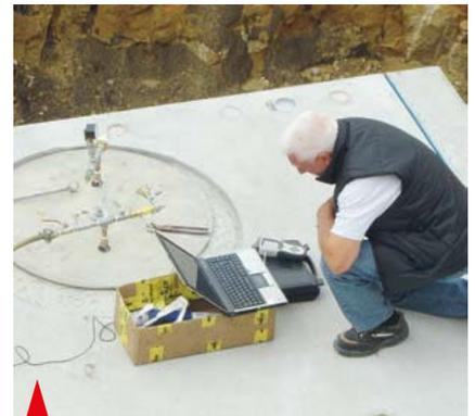
Uso de aire comprimido para comprobar la estanqueidad.
