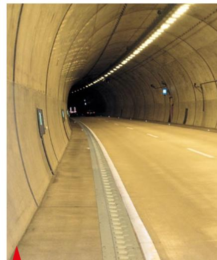
ACO DRAIN® drenaje de túnel
