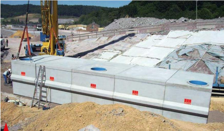
Ejemplo de instalación de un tanque de agua de 100.000 litros para extinción en la Universidad de Mainz, Alemania.
