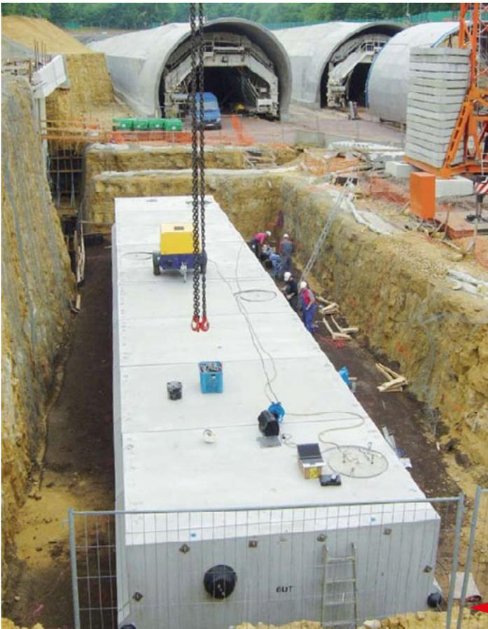
Contenedores grandes de ACO utilizados como tanques de emergencia y extintores de incendio en el Túnel de Stafelter.
